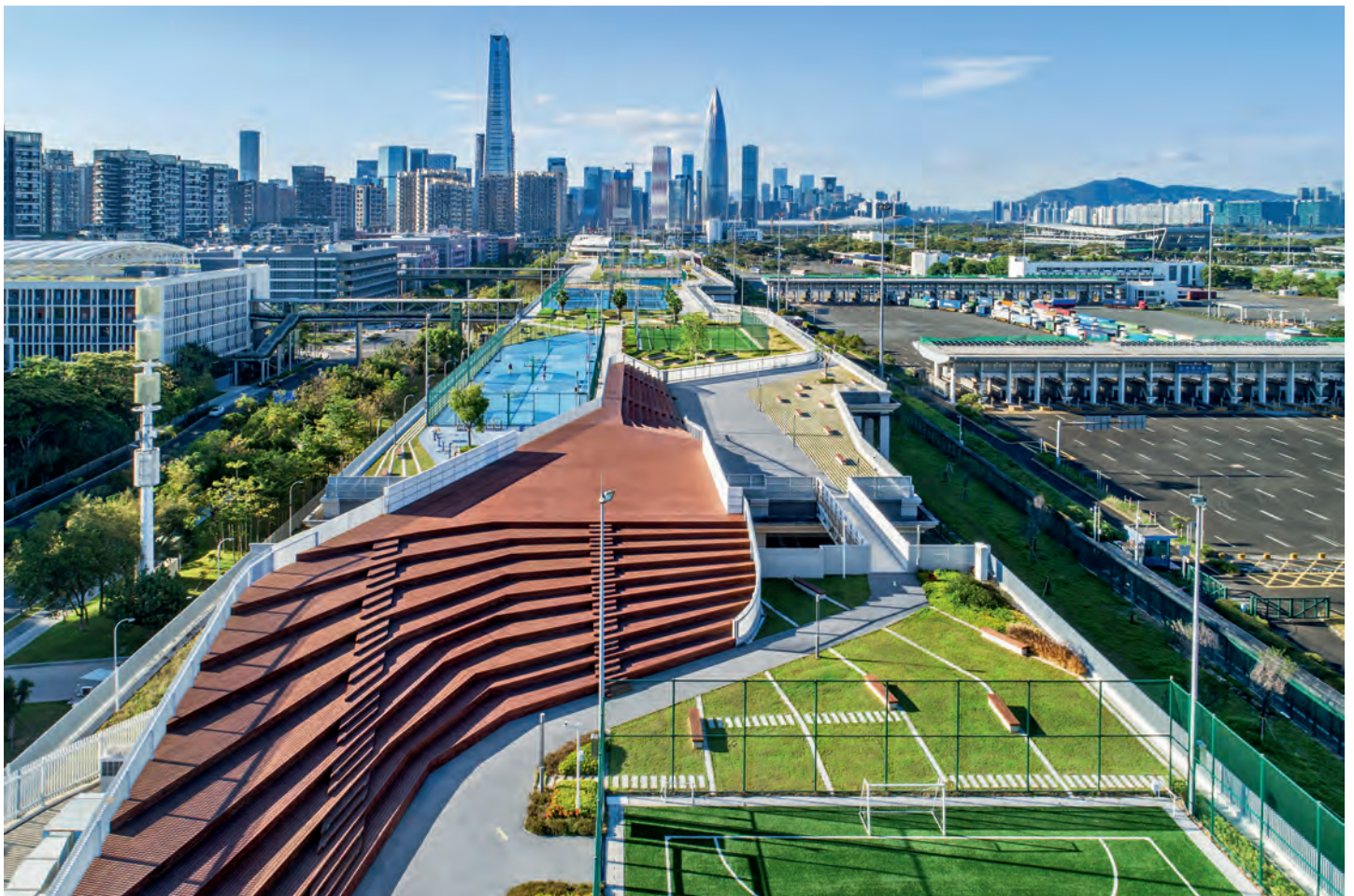
深圳湾体育训练基地宽大的屋面尺度 © 白羽
